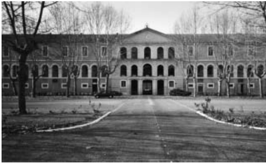
Le bâtiment principal
