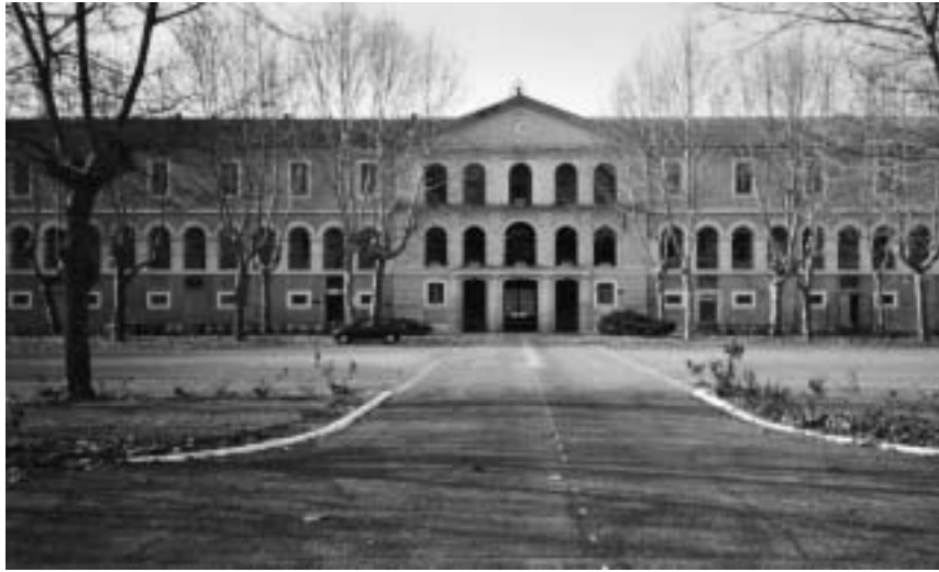
Le bâtiment principal
